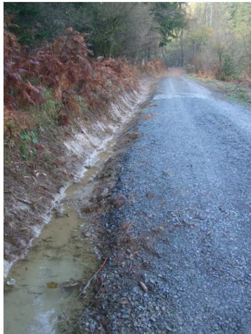
Ebenso wurden auf dem westlichen Weg im Römertal bis zur Fuchskuhl (die nach Lichtenberg führt) die Schlaglöcher aufgefüllt, der Graben an der Bergseite ausgebaggert und Querrinnen sowie Abflussrohre in-standgesetzt.
