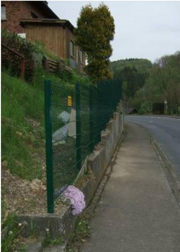
In der ersten Maiwoche hat die Firma Draht-Jung aus Gaderoth im Auftrag der Gemeinde Morsbach auf der langen Betonmauer einen neuen Zaun errichtet. Er ist sowohl ansehnlich grün beschichtet als auch stabil, da die Eisenpfähle in Betonsockel eingesetzt wurden. Wir müssen nun sehen, wie wir mit der Begrünung der grauen, tristen und hässlichen Mauer endlich weiterkommen.
